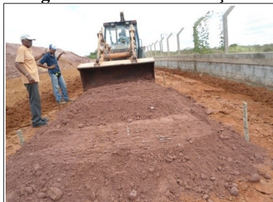
Figura 4: Solo sendo lançado
