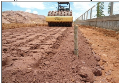
Figura 5: Solo sendo compactado
