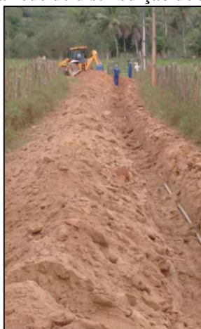
Figura 4: Ampliação da rede de distribuição de água de Alagoinhas-BA.
