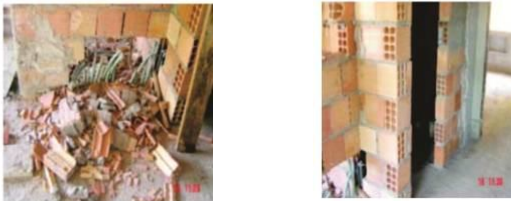
FIGURA 4.0 – Imagens antes e depois da aplicação da P+L em alvenarias
