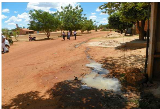
Figura 01: Esgoto a céu aberto na Rua Claudionor Ramos, Bairro: Vila Bahia. Fonte: PMSB Angical, 2015.
