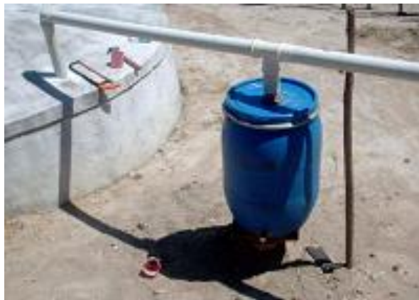
Figura 2 - Bombona para desvio das primeiras águas de chuva
