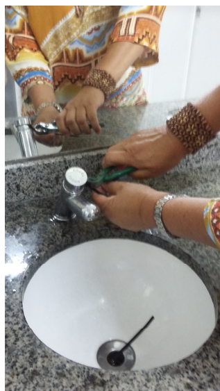
Figura 1: Processo de colocação da abraçadeira
