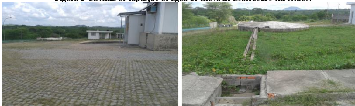
Figura 1- Sistema de captação de água de chuva no abatedouro em estudo.
