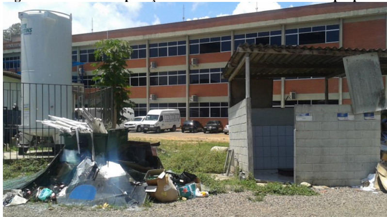
Figura 2 – Usina de separação do lixo e vidro fora do local apropriado.
